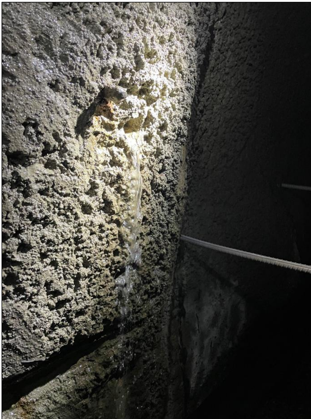
Foto 5. Eksempel på lekkasje fra boltehull. Start av tunnel, bak hvelv, høyre side retning Alta.
