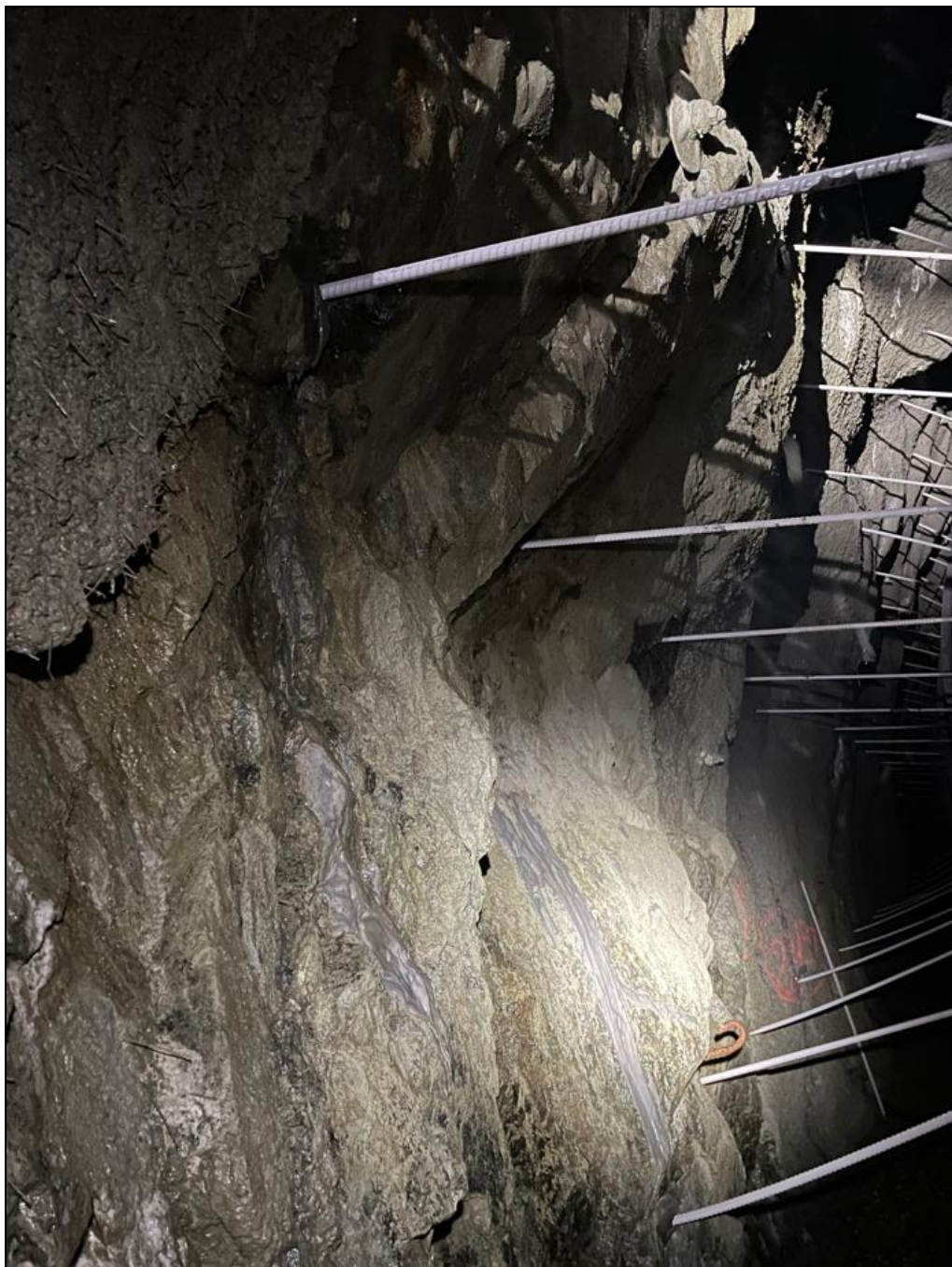
Foto 7. Eksempel på parti med manglene sprøytebetong. Pel 210 venstre hvelv, retning Alta.
