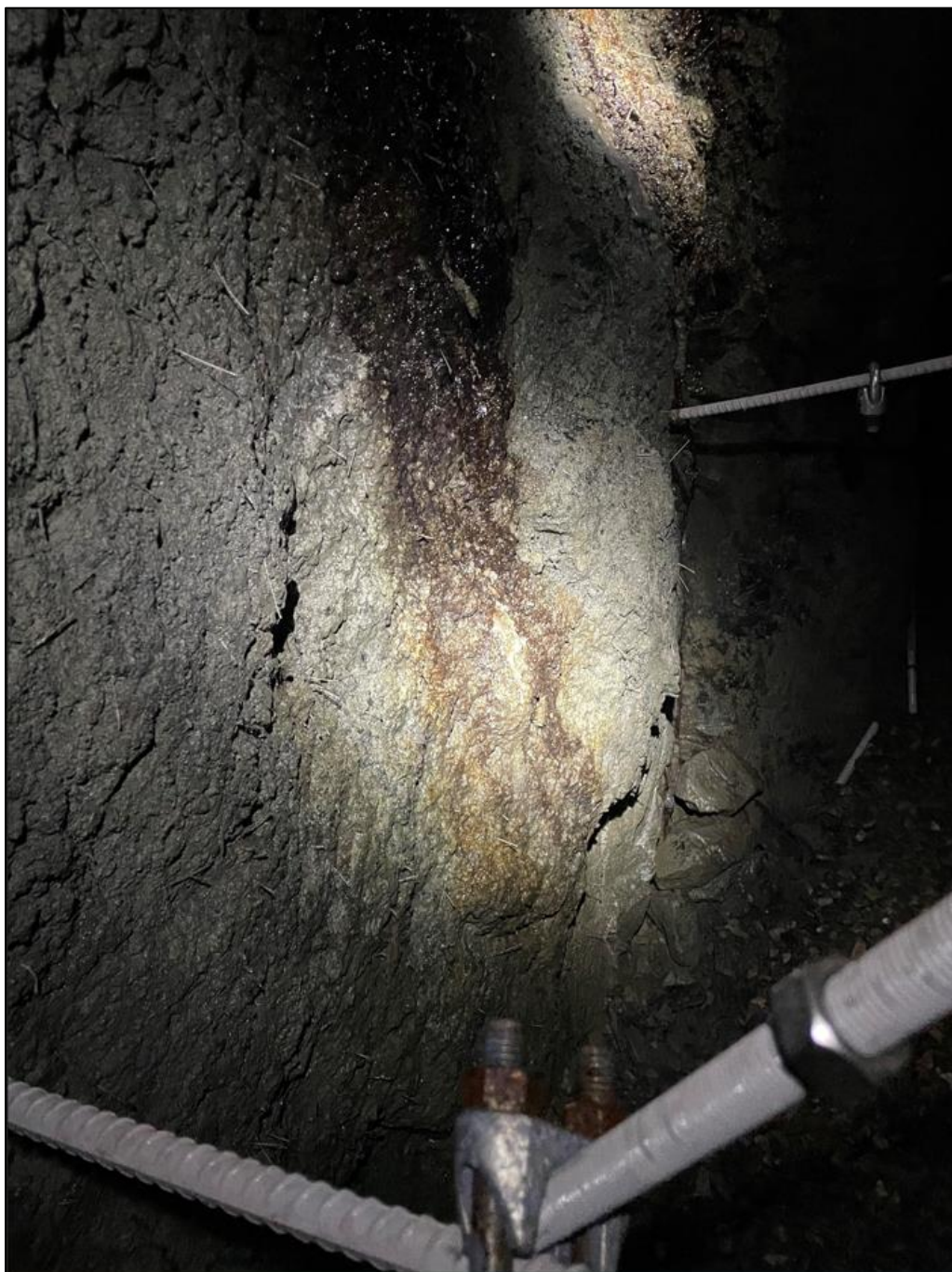
Foto 4. Eksempel på fukt/vann bak hvelv, og rustet bolter. Pel 1860 høyre side hvelv, retning Alta.
