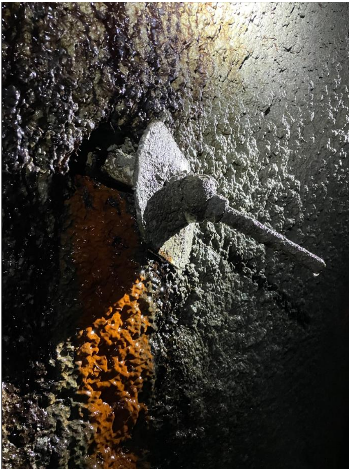
Foto 6. Eksempel på bolt med løs bolteskive, og fuktige forhold bak hvelv. Pel 1045 venstre hvelv, retning Alta.
